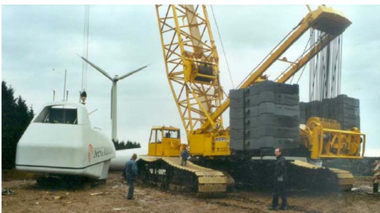
Montage der 3 NEG 1000kW für Windwin im Schwarzwald nördlich von St. Peter Nov. 2000 ( www.windwin.de )
